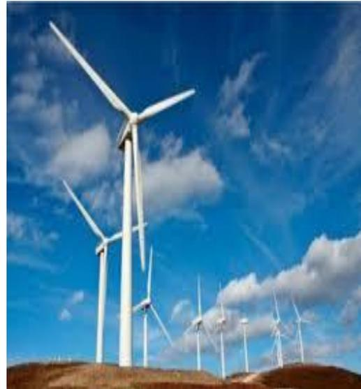
**Figure1. 17 Eoliennes à axe horizontal**
