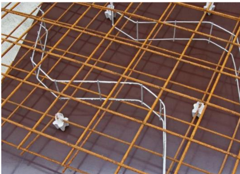
Figure I.15 : Les écarteurs de nappes d'armature.
