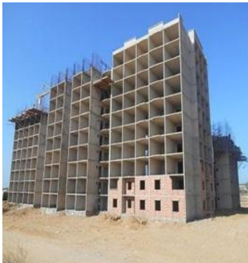
Figure I.29 : Exemple des bâtiments réalisés en coffrage tunnel.
