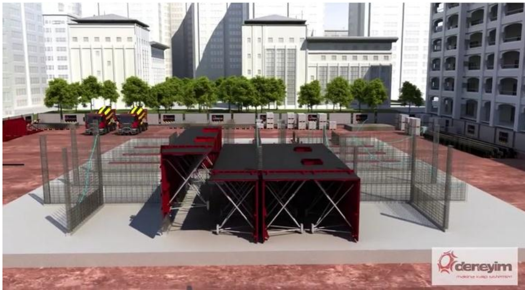
Figure I.22 : La mise en place des demi-coquilles.
