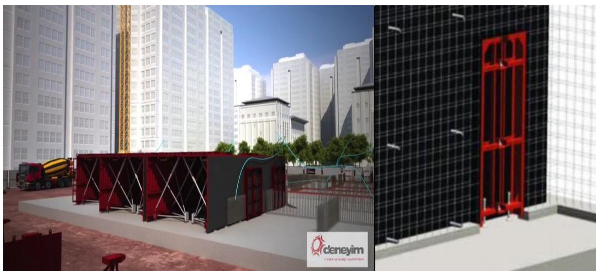
Figure I.23 : Mise en place des divers réserves.
