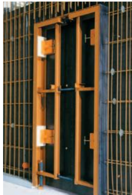
Figure I.11 : Cadre de réservation.
