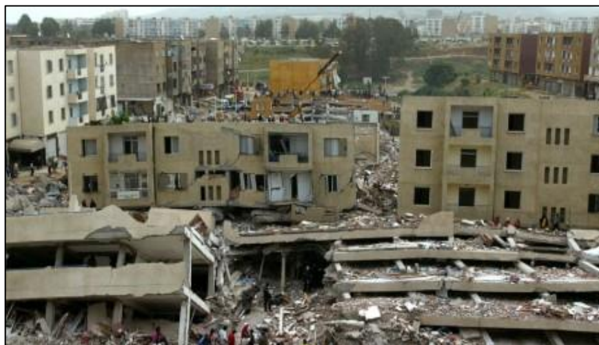
Figure I.1 : Séisme de Boumerdès 21 Mai 2003
