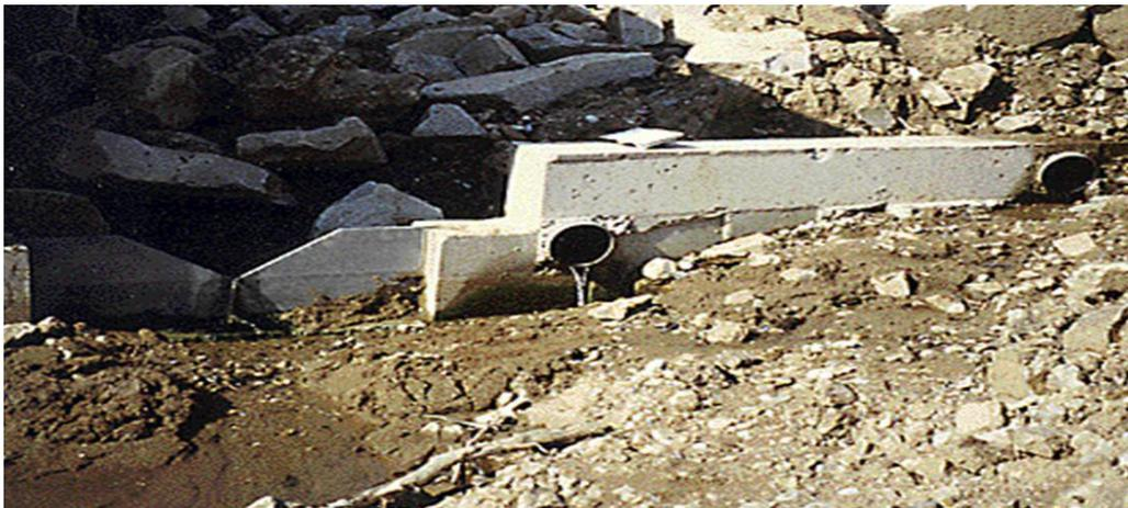
**Figure II.5 :** Débit de drainage collecté au niveau du barrage de Sikkak, wilaya de Tlemcen (Smail, 2007)
