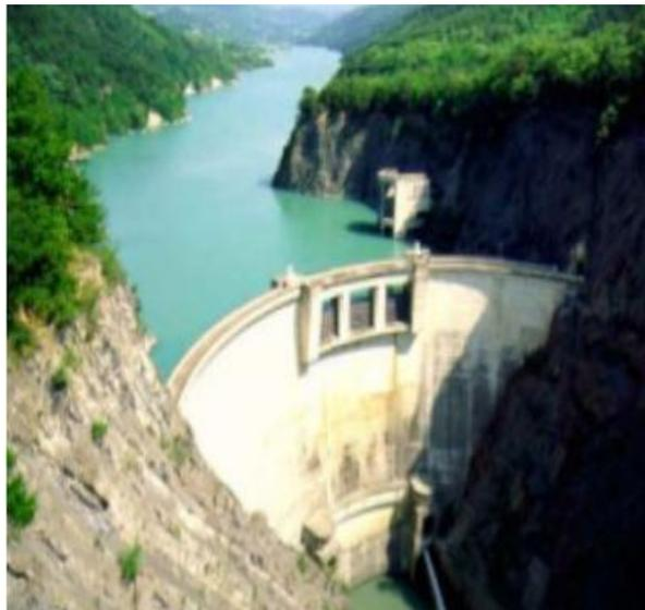
Figure I.2 : Exemple d'un Barrage voûte (barrage de St-Pierre Cognait)
