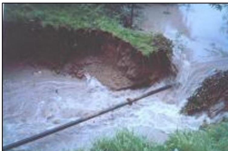
**Figure II.4 :** Renard autour d'une canalisation traversant la digue(Samir, 2017)
