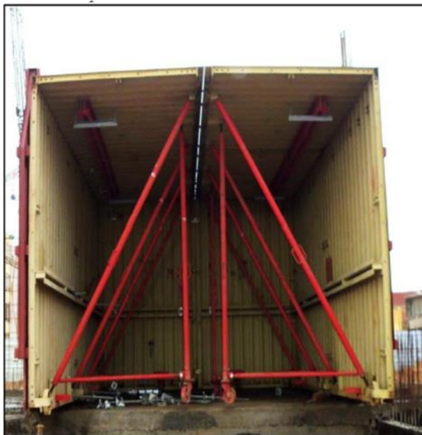
Figure I.5. Assemblage de deux demi coquille sur chantier .
