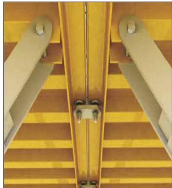
Figure I.6. Deux panneaux horizontaux solidarisés à l'aide verrous à clef .
