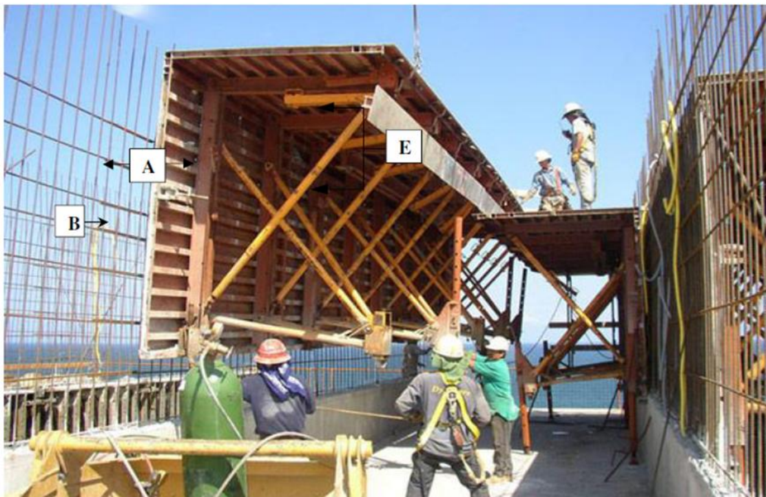
Figure I.3. Une demi coquille sur chantier.
