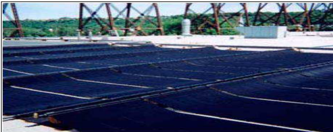
Fig. I.8 : Capteur plan non vitré [11]
