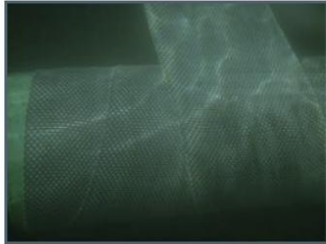
Figure III.2: Emballage de composite flexible pour la réparation sous – marine
