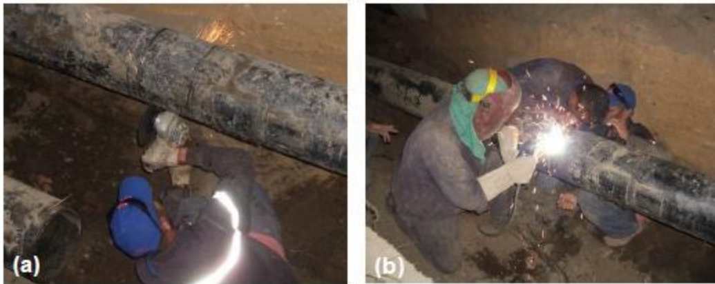
Figure III.9 : changement du tronçon endommagé d'une canalisation, (a) découpe, (b) Ré-soudage
