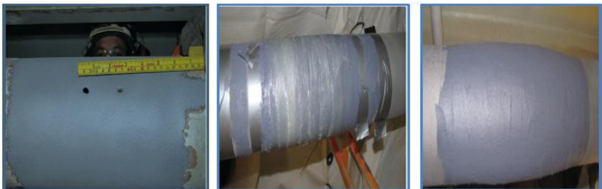
Figure III.1: Réparation par composites d'une pipe en acier
