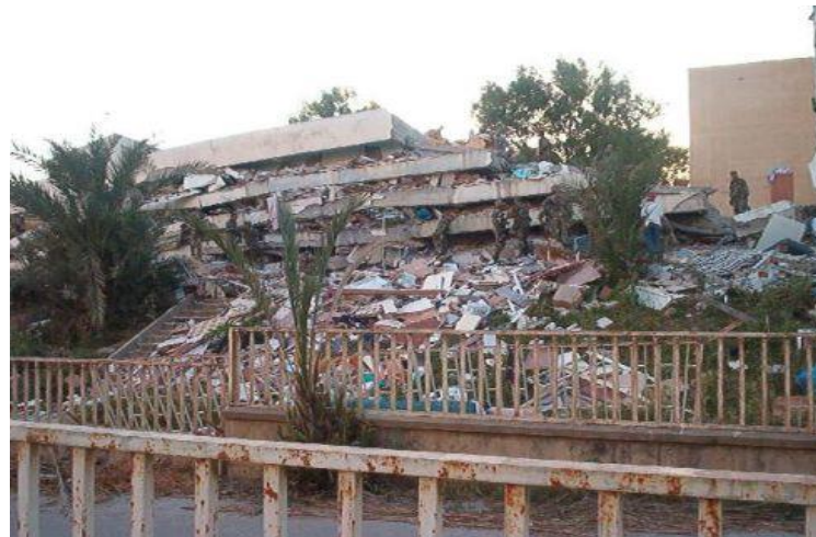
Figure 1.4. Séisme de Boumerdes.
