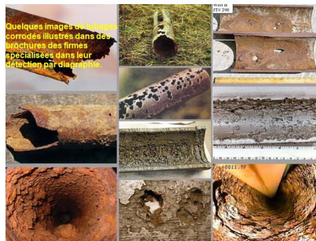
Figure 27 Quelques images de tubage
