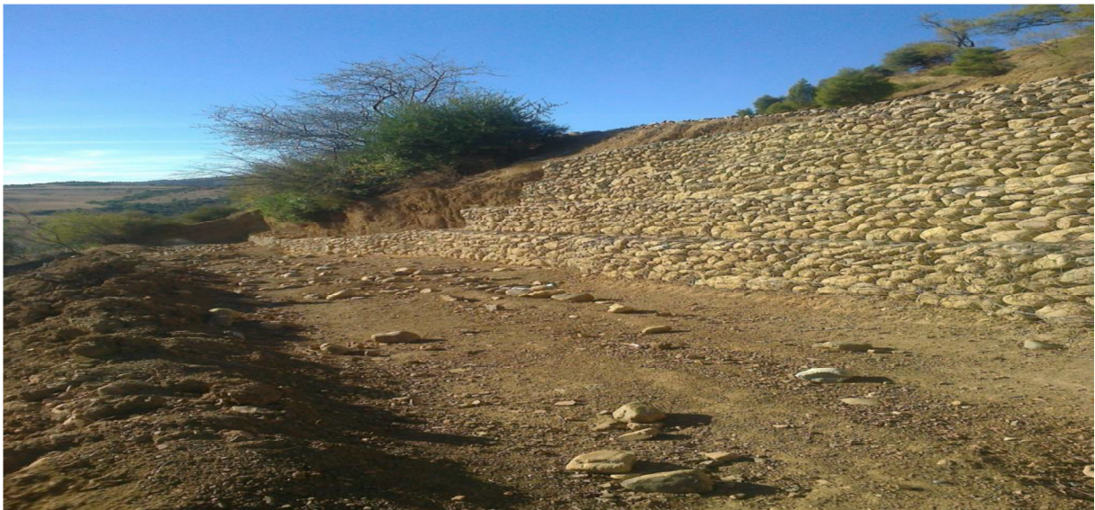
Figure 22. Gabions réalisés sur la rive gauche de la chaussée (Photo DTP, inédit, 2017)
