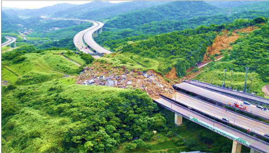
Figure 10. Éboulement ou écroulement [5]
