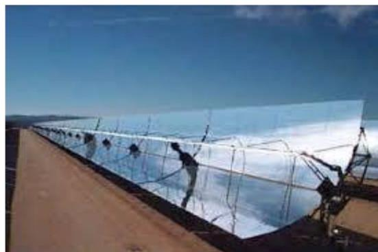
Figure I.4 Concentrateur cylindro-parabolique. [13]
