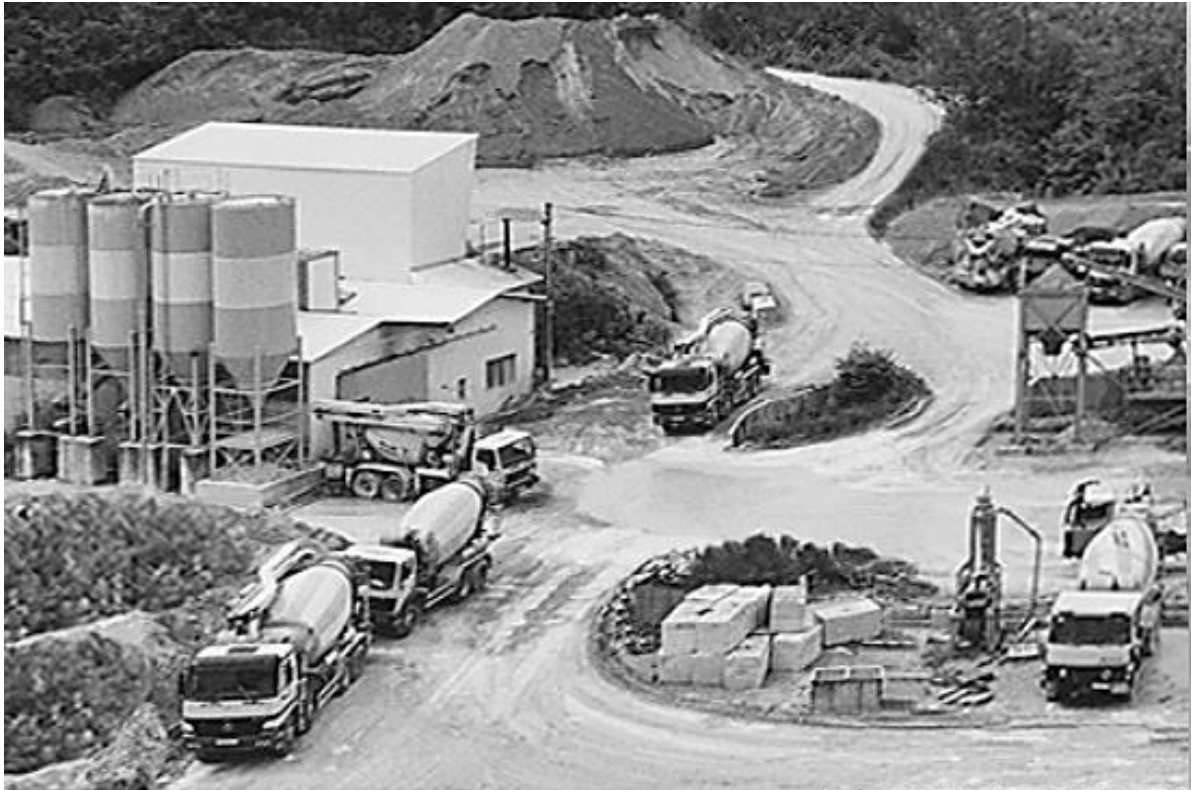
Figure I.14 Transport du béton à l'aide des bétonnières.
