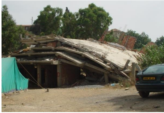
(a) : Écroulement en mille feuilles.
