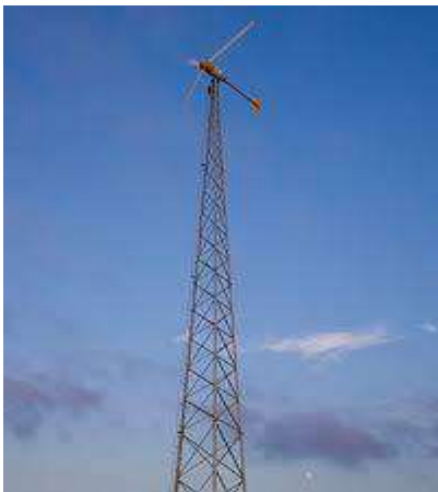
Figure II-1 : éolienne avec tour en treillis
