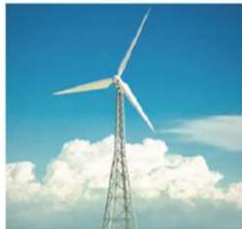
Figure II-1 : éolienne avec tour en treillis
