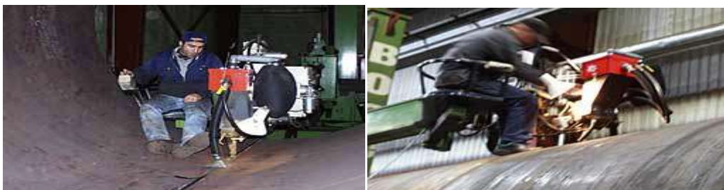
Figure II-6 : soudage des sections de la tour [4]
