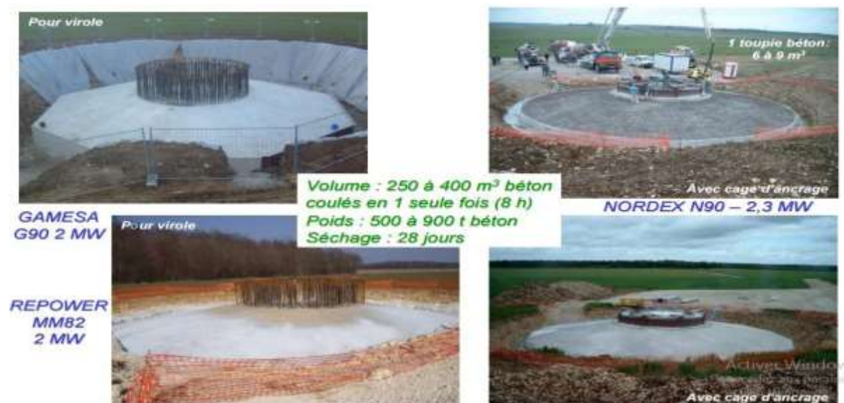
Figure II-8 : fondation de l'éolienne terrestre [6]
