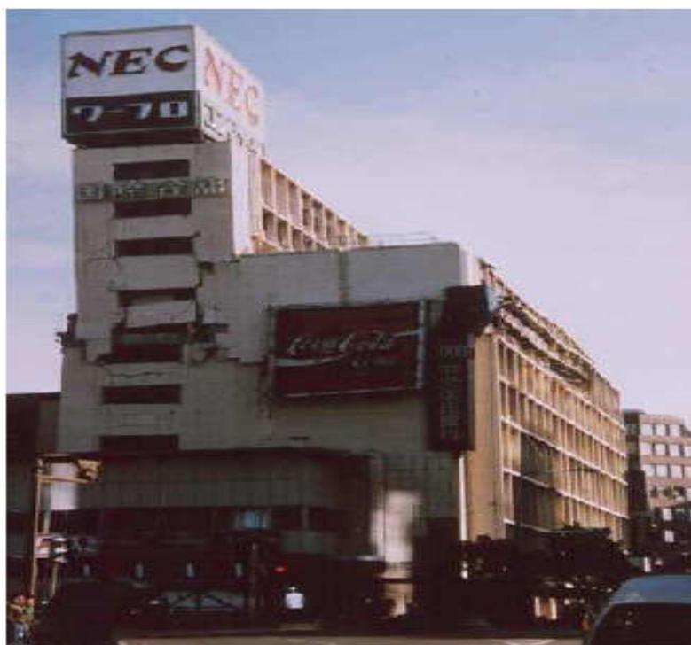
Figure I.12.2 : Dommages dans les angles rentrants dans le plan vertical dus aux oscillations Différentielles [12]
