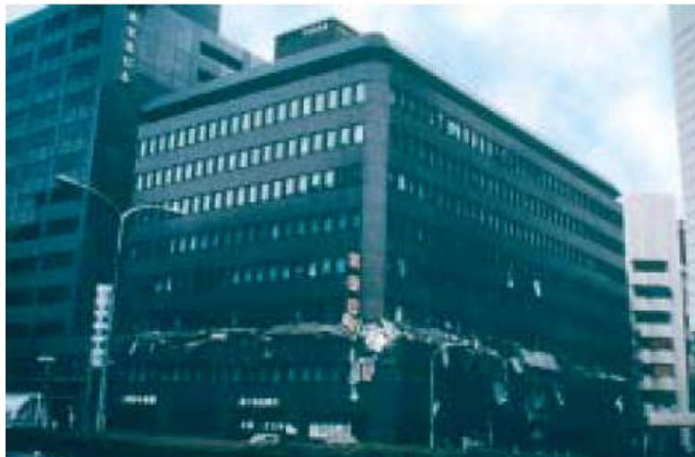
**Figure I. 8 :**Le troisième étage de cet immeuble commercial a disparu. La partie supérieure s'est affaissée d'un étage (Kobe, Japon, 1995).
