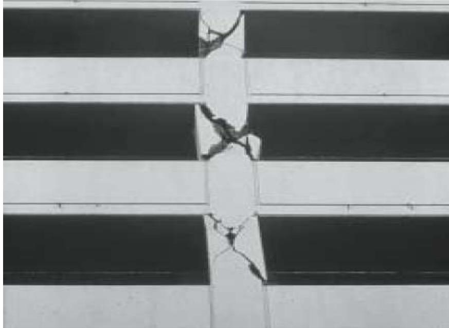
**Figure I.11** : Les fissures en croix et les ruptures par effort tranchant qui ont affecté les colonnes courtes de ce parking ont presque entraîné son effondrement (Northridge, Californie, 1994).
