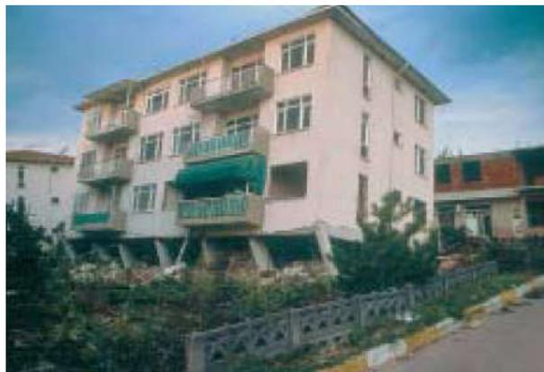
Figure I. 7: Les colonnes antérieures se sont inclinées dans leur direction de
