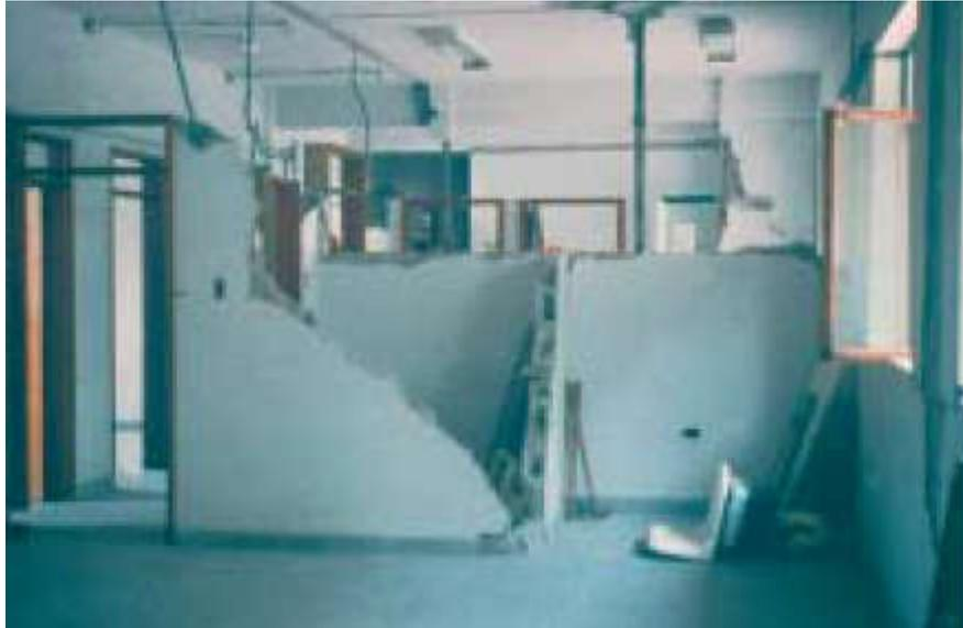
**Figure I.10** : Dans ce cas, les cloisons non-porteuses ont été détruites, bien que la structure en cadre ait subi des déformations et des dégâts mineurs, et que les fenêtres soient restées intactes (Arménie, 1988).
