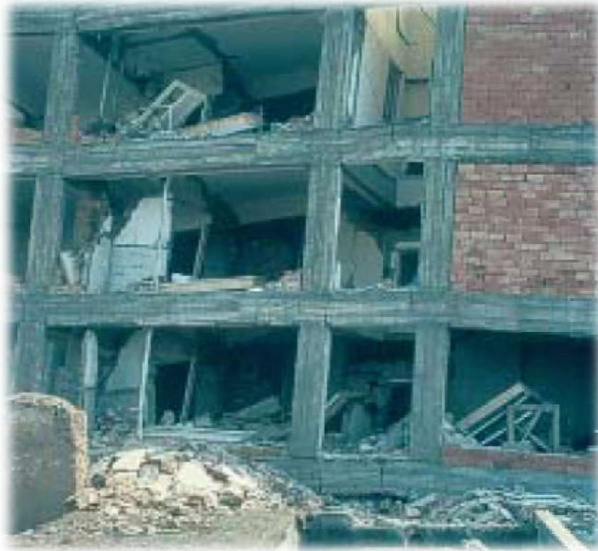
**Figure I.9 :**les colonnes étaient manifestement les plus résistantes. Une grande partie de la maçonnerie est tombée, mais le cadre a tenu (Erzincan, Turquie, 1992).
