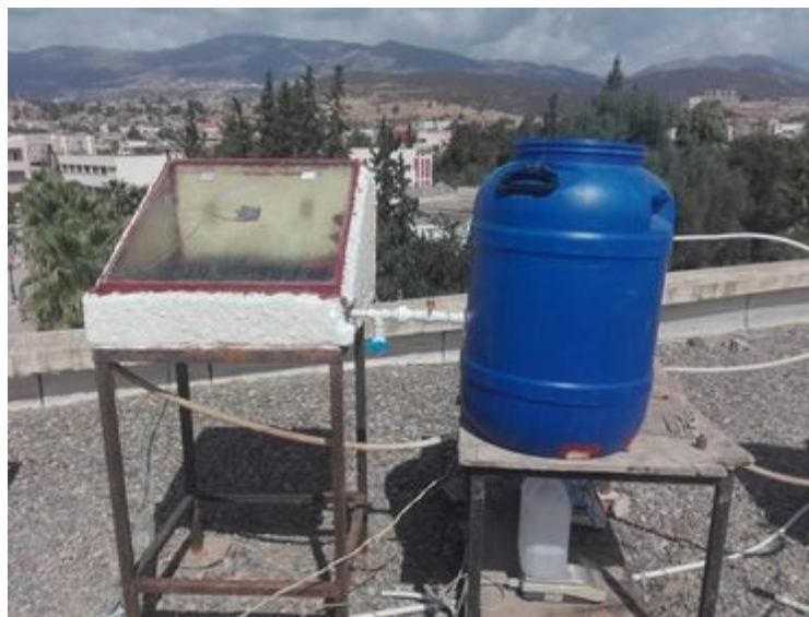
Figure II-1 : photographie du banc d'essai
