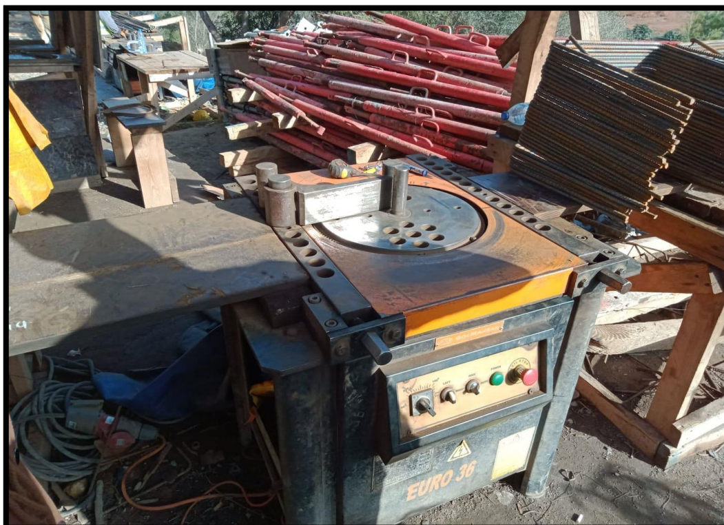
Figure I-35 : Poste de ferrailage avec cisaille.
