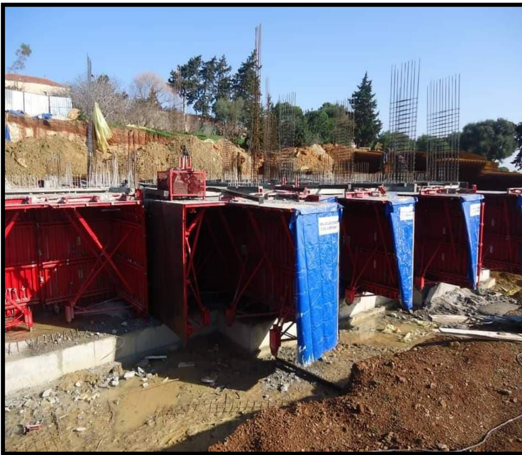
Figure I-9 : Mise en place des demi-coquilles.
