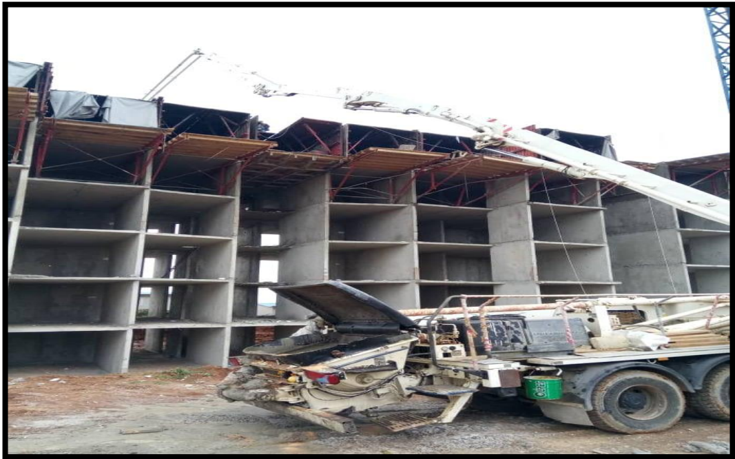
Figure I-32 : Transports et déchargement de béton jusqu'à 28 mètres en malaxeur-pompe.
