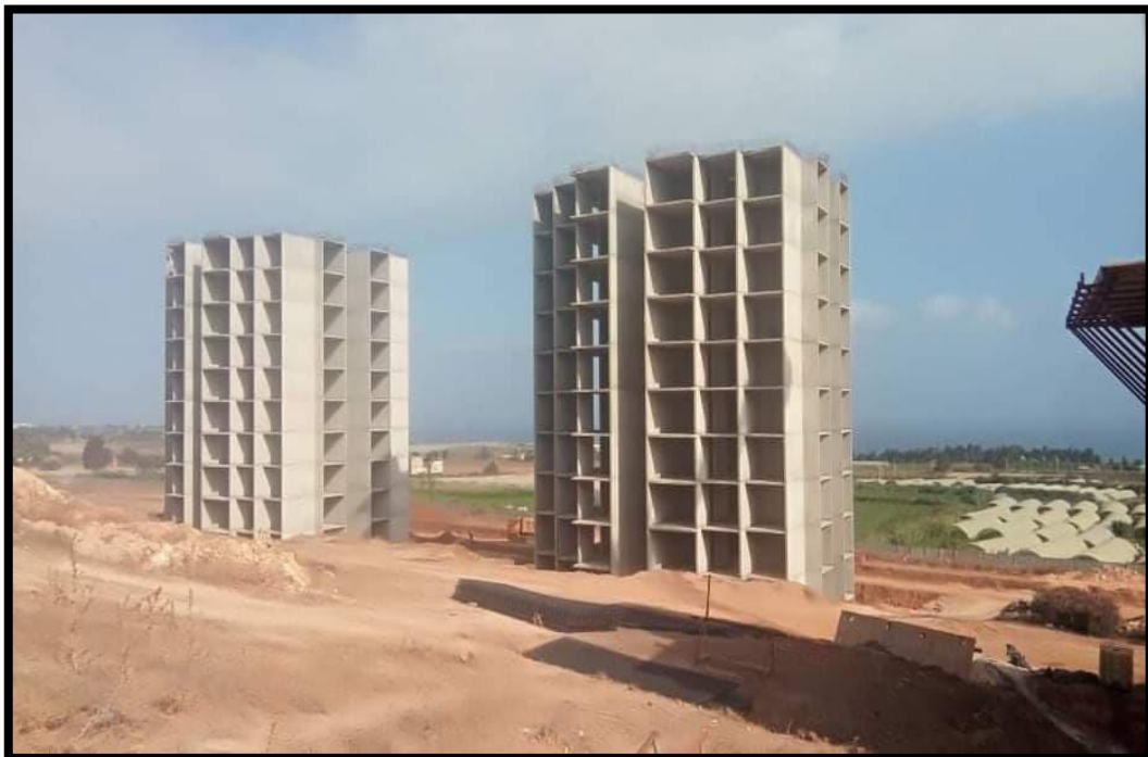
Figure I-3 : Bâtiment en coffrage tunnel.
