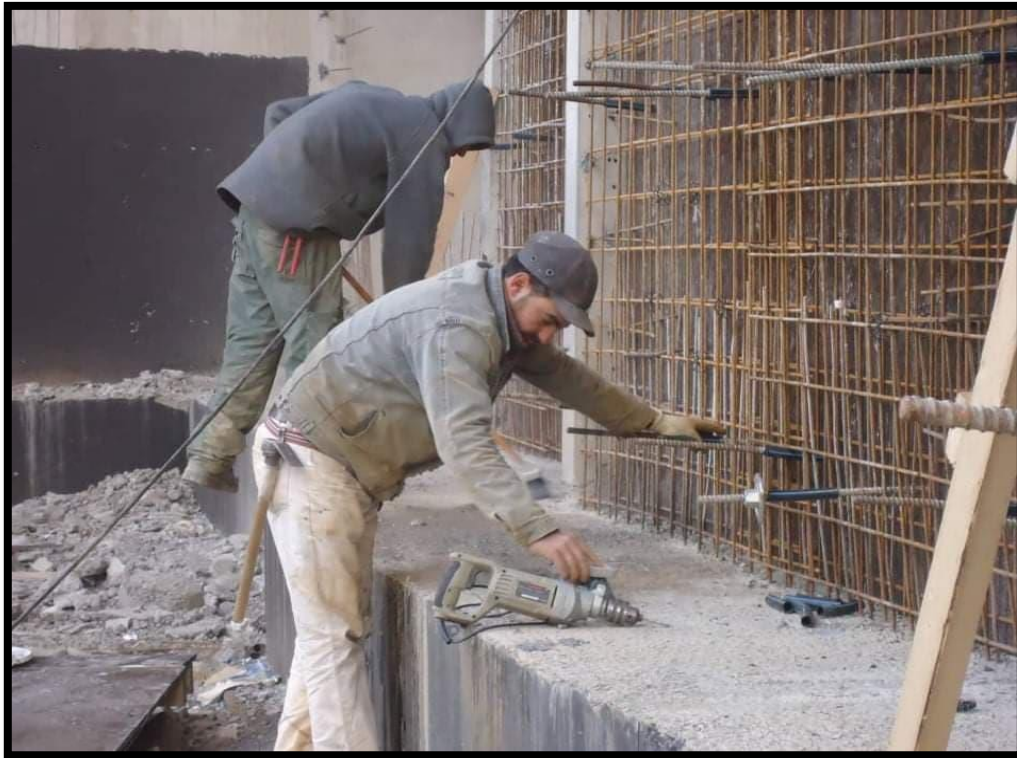
Figure I-5 : Disposition des armatures.
