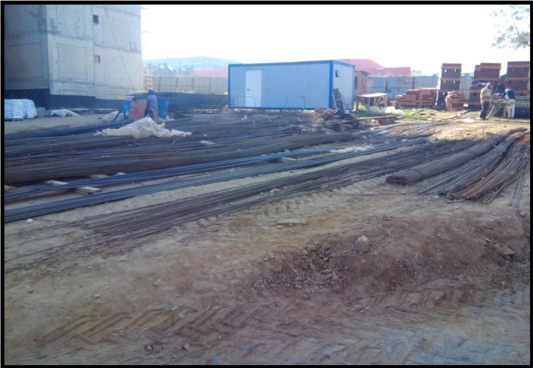
Figure I-37 : Les armatures d'acier.
