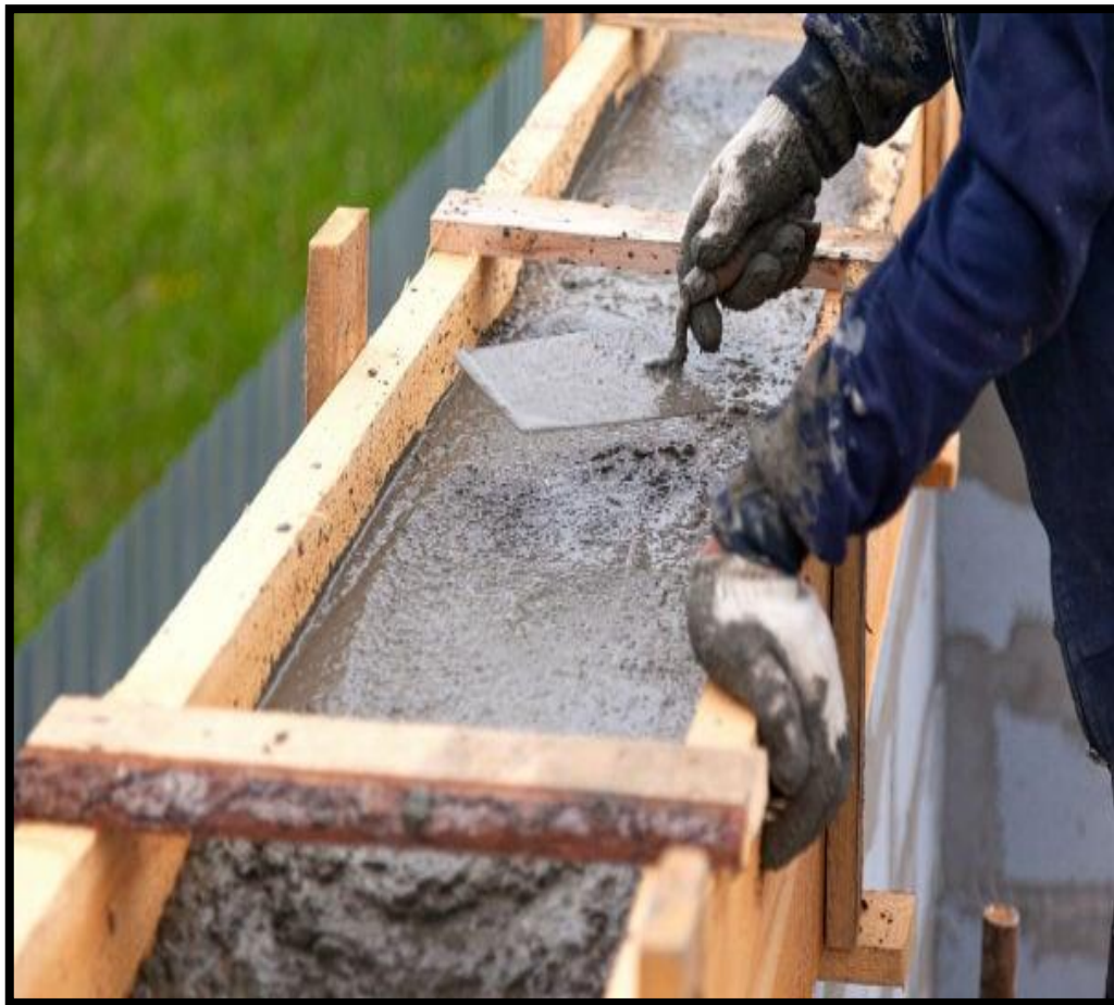
. Figure I-2 : les coffrages horizontaux.
