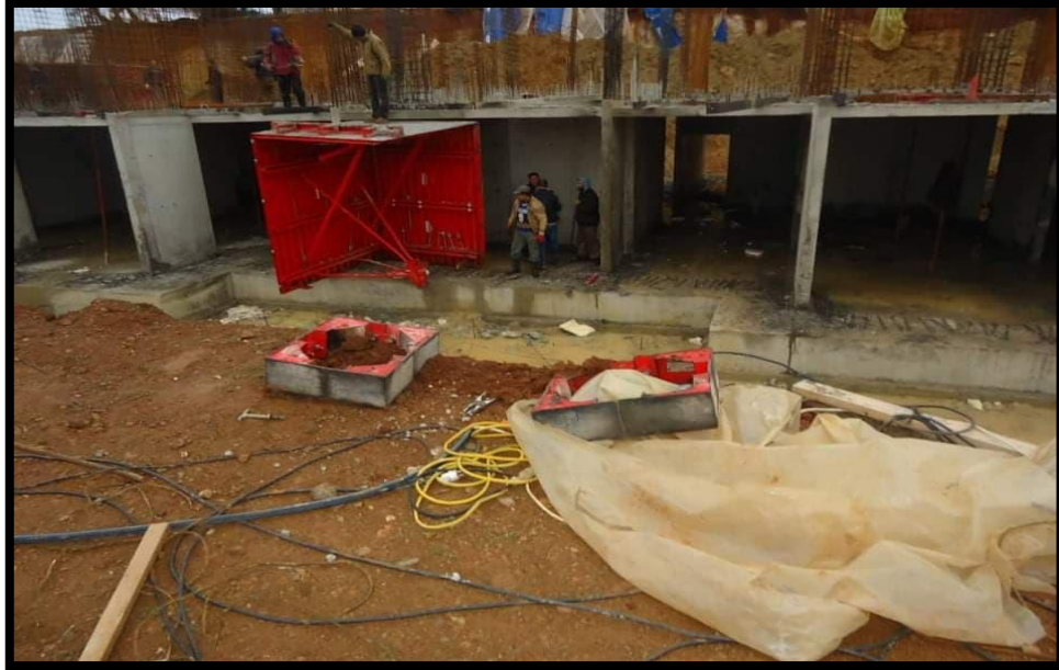
Figure I-10 : Mise en place des banches pignon.
