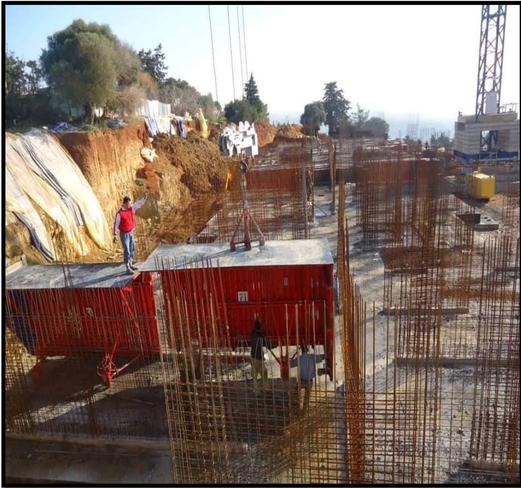
Figure I-6 : La mise en place des demi-coquilles.
