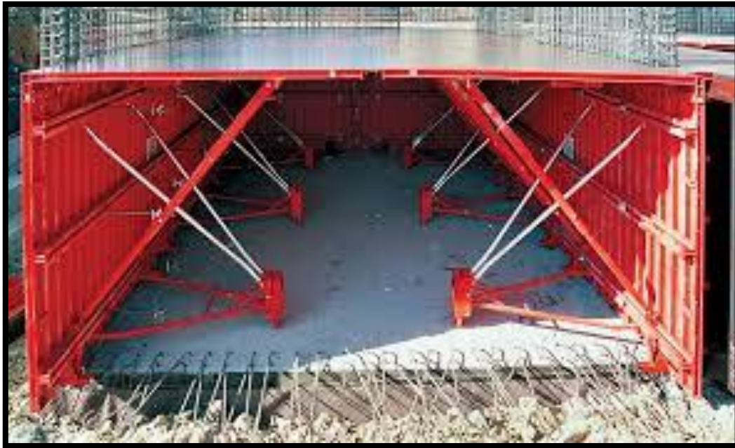
Figure I-7 : Chambre de coffrage.
