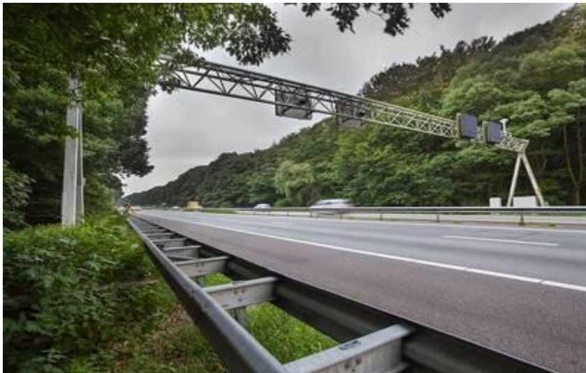
Fig.1.4 : Utilisation du système VIRONIC pour la surveillance routière [4].
