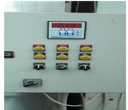
Figure 17 : Le réglage automatique de la température
