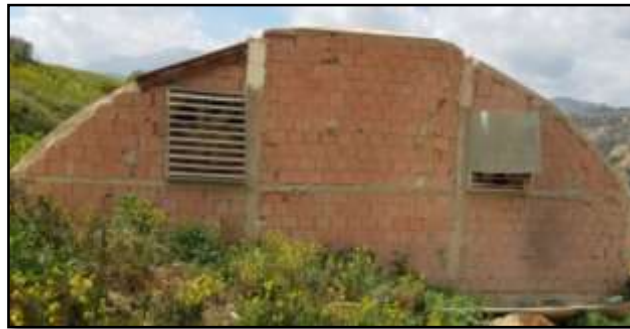
Photo N°3 : Mur en briques (Photo personnelle).
