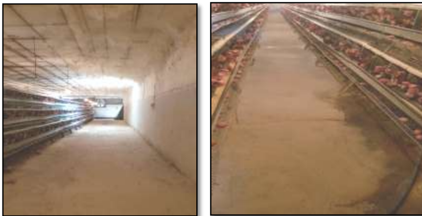
Photo N°2 : Sol en béton (Photo personnelle).
