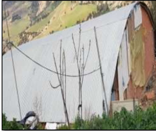
Photo N°5 : Toiture en zinc (Photo personnelle).
