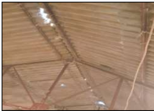
Photo N°6 : Toiture en éternit (Photo personnelle).
