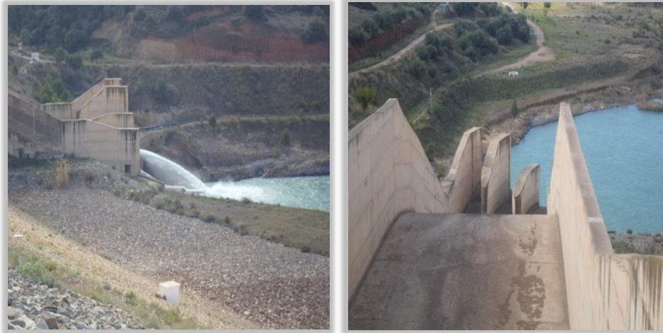
Figure 10 : Exemple d'évacuateur des crues « barrages SMBT » (originale 2020)
