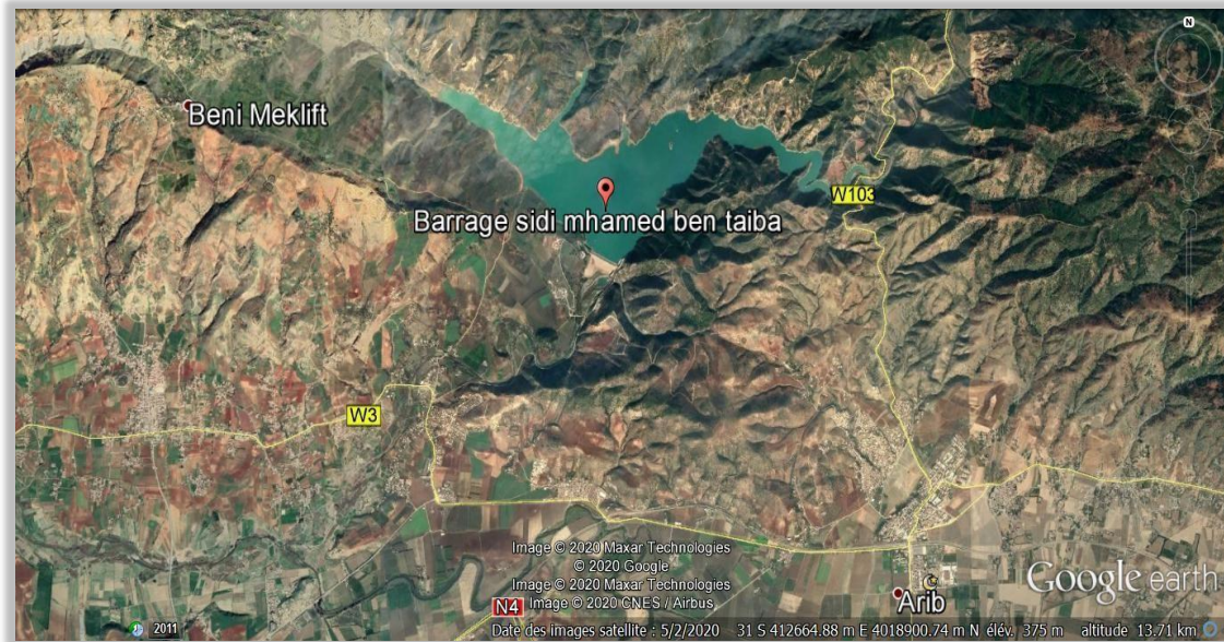
Figure 13 : vue du barrage de Sidi M'Hamed Ben Taïba (Google earth,2020)
