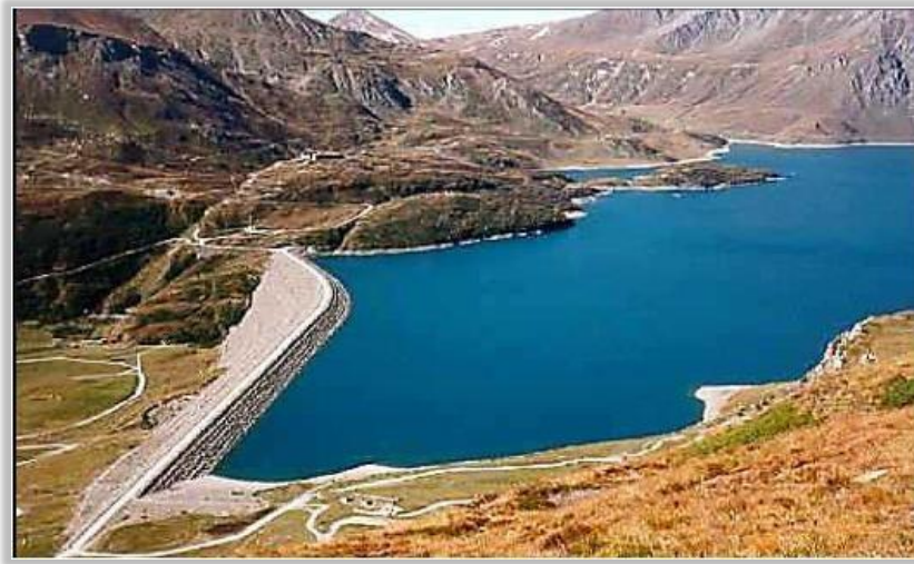
Figure 7 : Le barrage en terre (Heragmi, A.2009)
