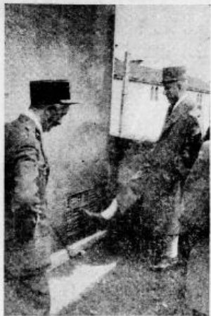
L'indivisionnaire Luchini dirige la place où les terroristes avaient creusé une tranchée dans le sous-sol de l'édifice.
