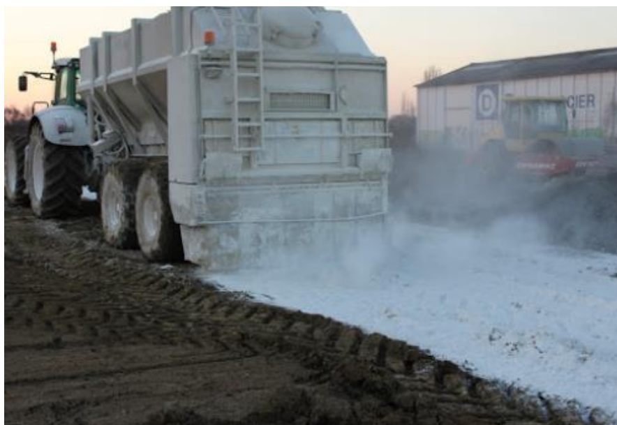
Figure 1.12 - Epannage de la chaux sur un sol à traité (France).
