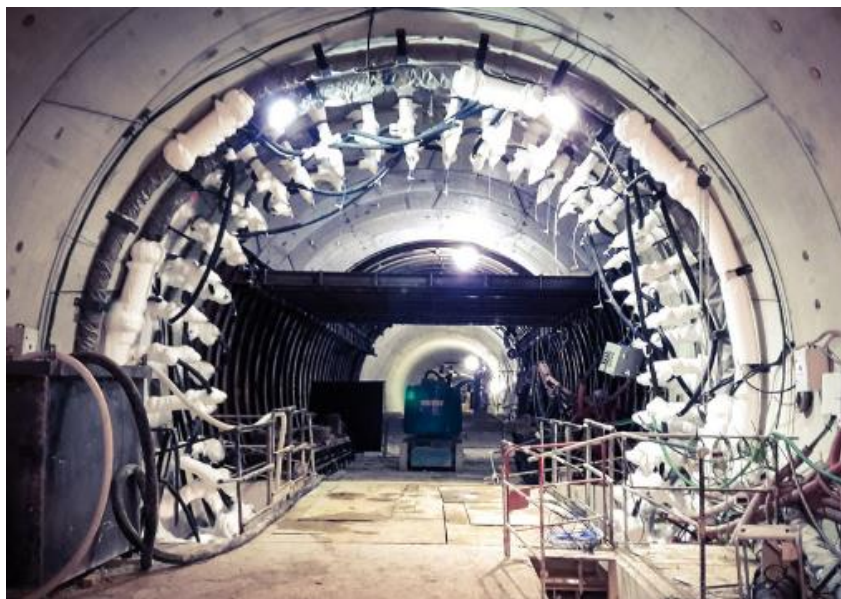
Figure 1.11 - Stabilisation du sol par congélation en France
