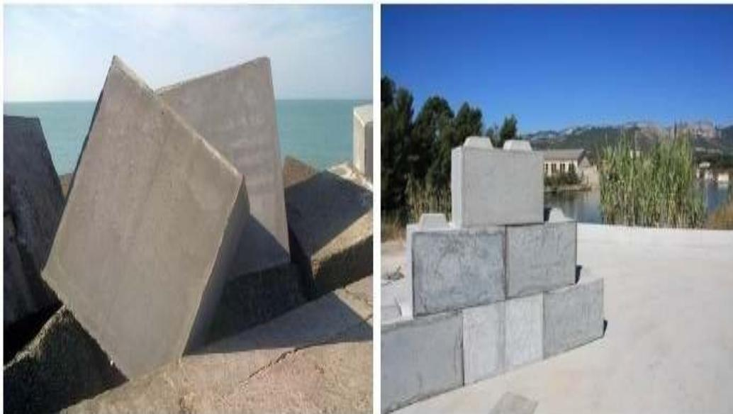
**Figure 11.** Blocs de bétons réalisés avec des sédiments non-immérgeables traités (droite : Port de Dunkerque, gauche : Rade de Toulon) (Boukemmoum, 2019)
