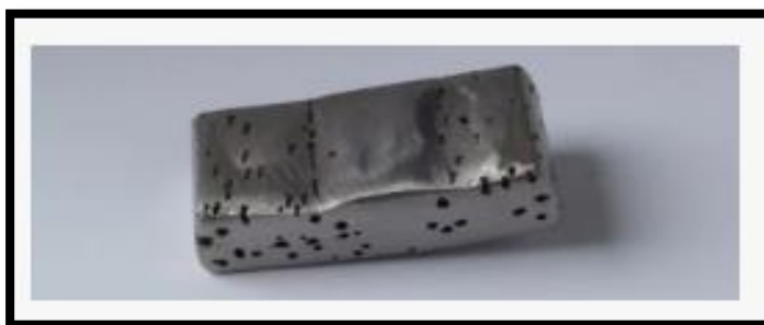
Figures I -5- corrosion par piqure
