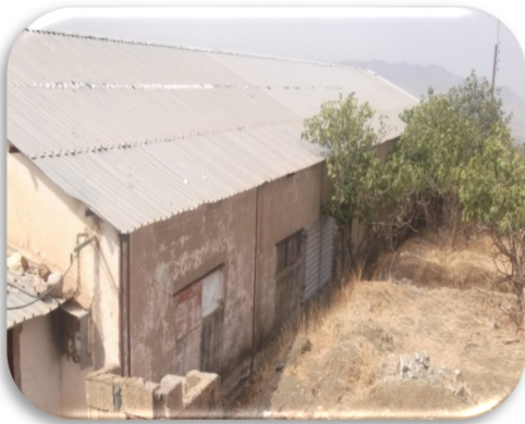
Photo 6 : Toit en tôles de zinc .
