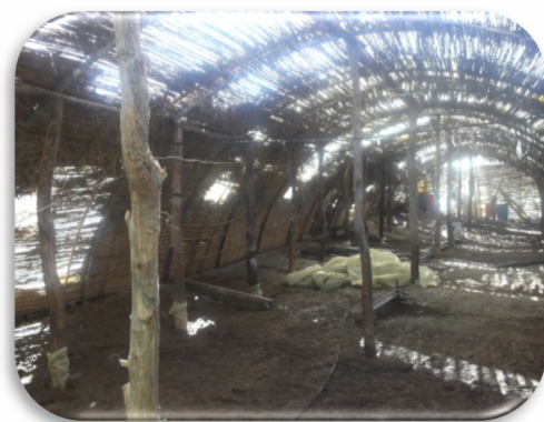
Photo 9 : Toit en roseaux.
