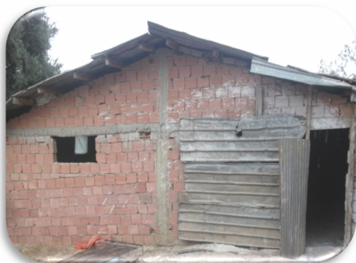
Photo 4 : Mur en briques .
