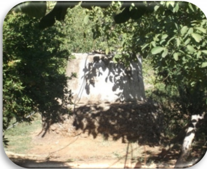
Photo 19 : Présence d'un puit au bâtiment d'élevage.
