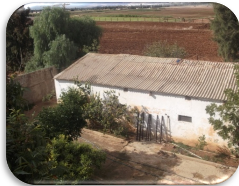
Photo 7 : Toit en éternit .
