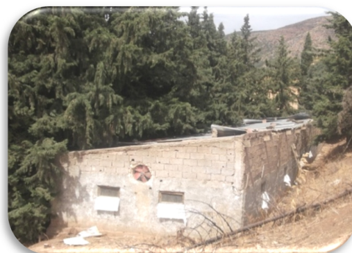
Photo 5 : Mur en parpaing.
