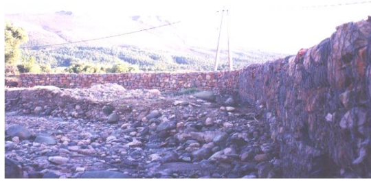
Photo n°12: Mur en gabions, construit par l'Etat (Tizgui au Maroc).
