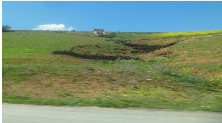
Photo n° 23: Aménagement des ravins Seuil en Gabion Canton Ouledji (Cliché : Bahloul et Chaouchi, 03/04/2016)
