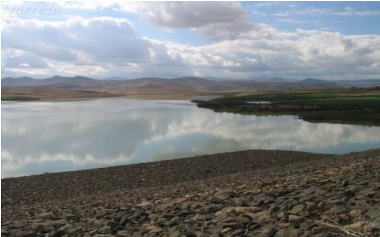
Photo n°14: Barrage Harreza (Cliché Bahloul et Chaouchi 2016)
