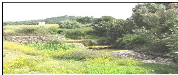
Photo n°13: Un zoom sur un seuil construit en maçonnerie sur un ravin dans la région rifaine au Maroc. (Roose, 2000).
