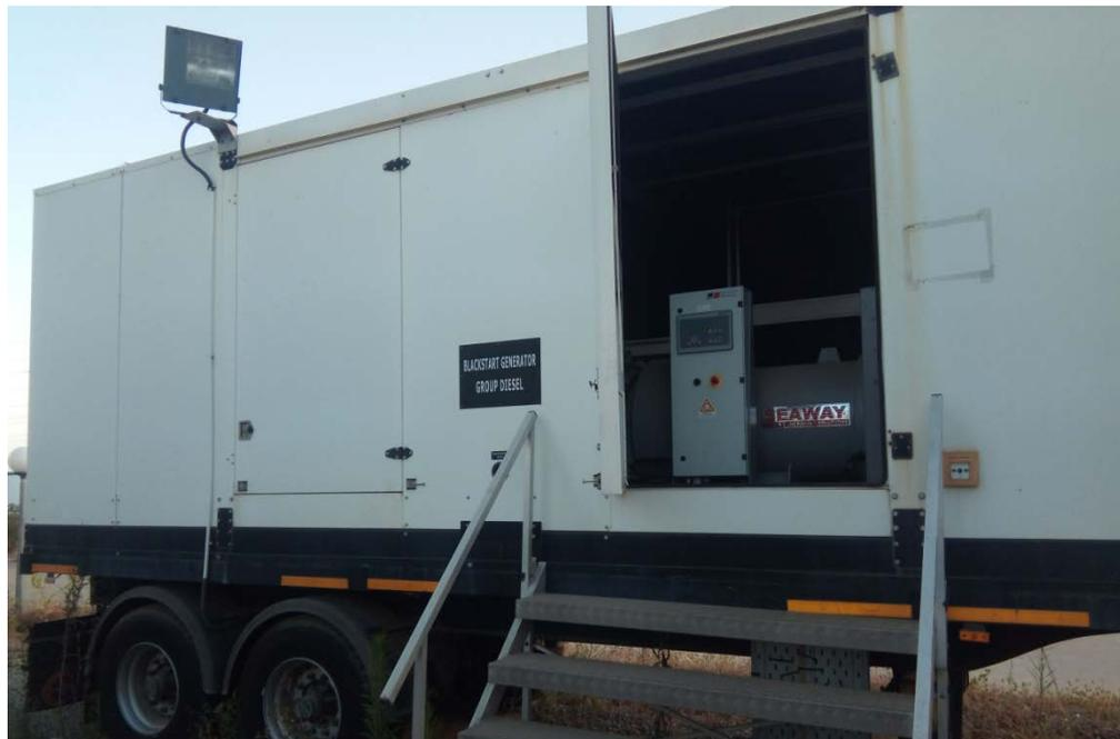
Figure : II. 5 Remorque diesel secours
