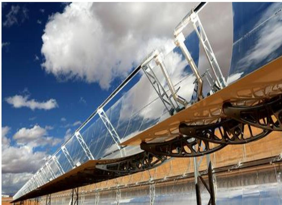
Figure 8 : Capteur cylindro-parabolique [28]
