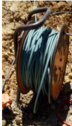
Figure.4.12 : Câble de 400 m
