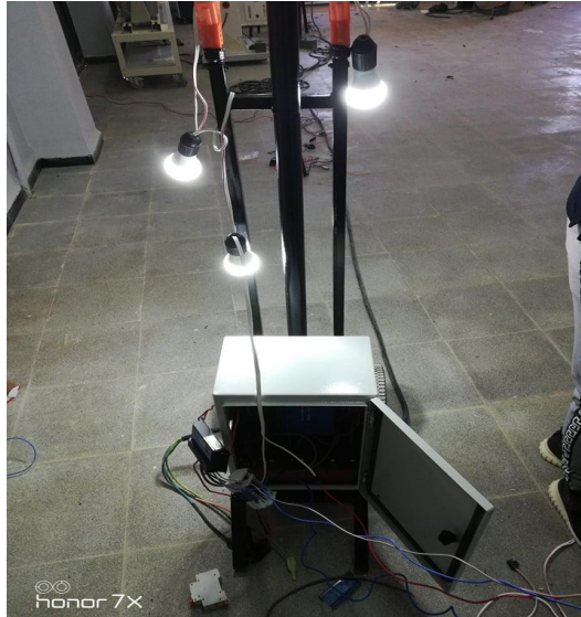
Figure IV- 1 : Expérience de la décharge des batteries.
