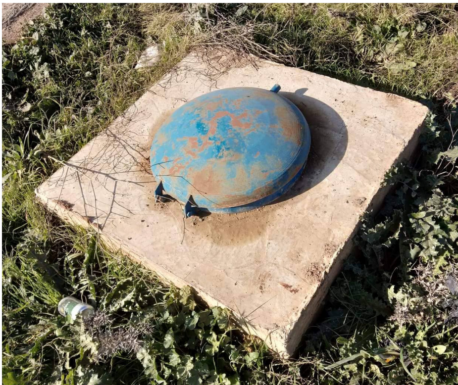
Figure 2. - Station piézométrique de référence affiliée à l'ANRH
