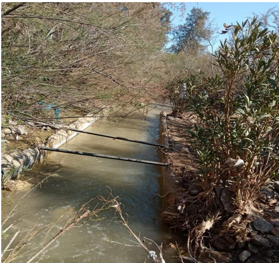
Figure 3. Canal de mesure de la station de référence de l'ANRH de l'Oued Harreza
