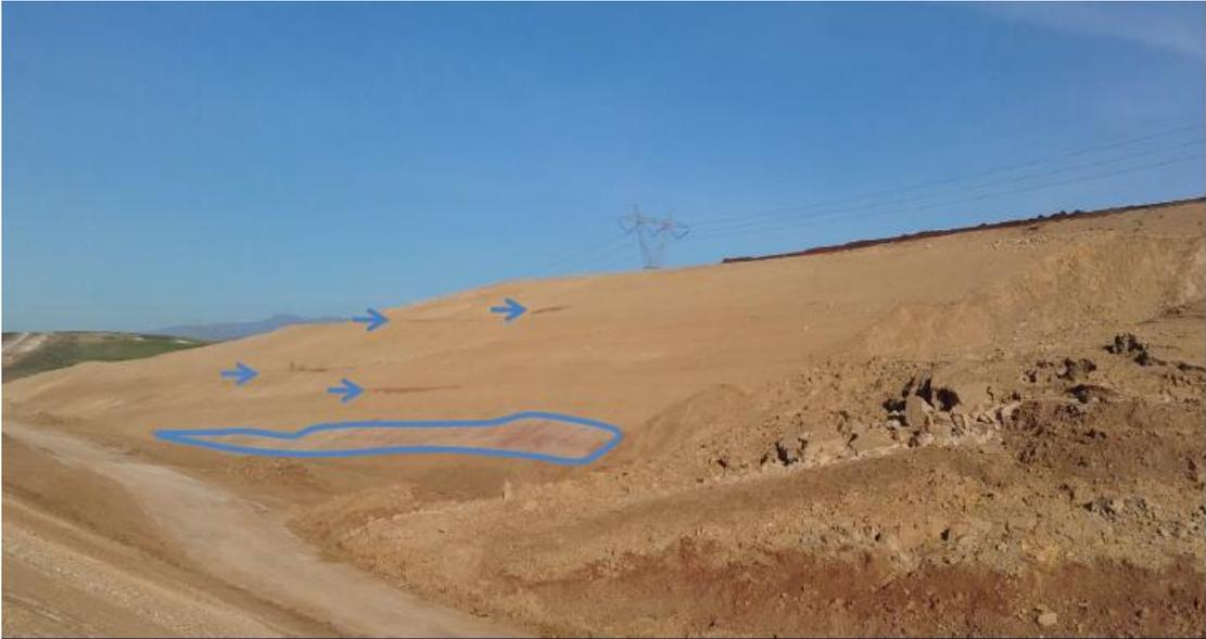
**Figure.2-4 :** Couches transportant de l'eau sur le talus gauche du PK 7 + 450
