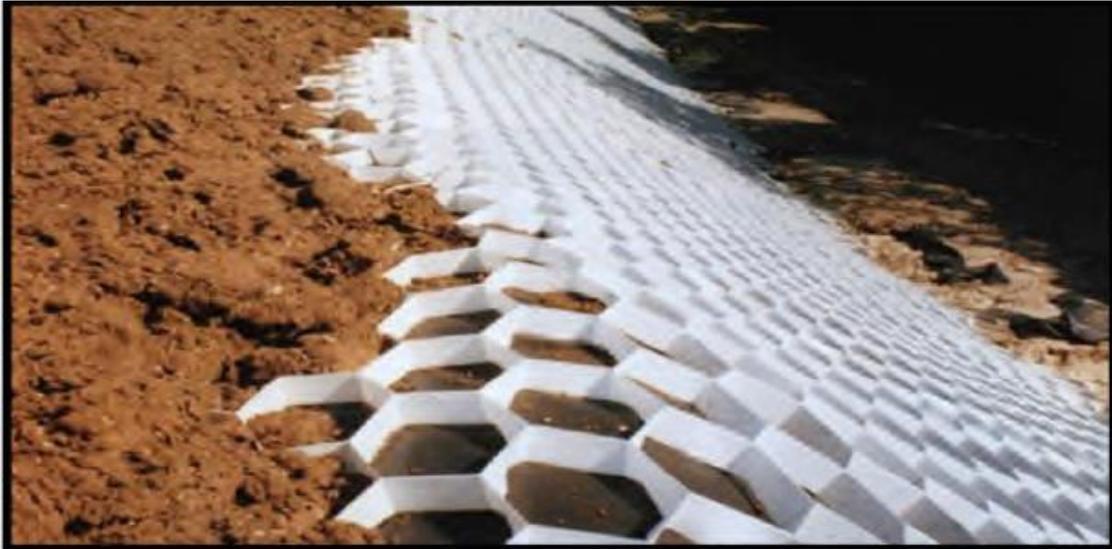
**Figure.1-25** : Renforcement par géotextiles
