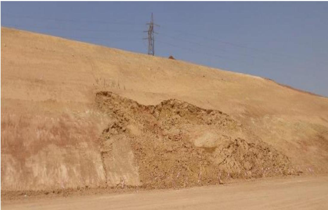
**Figure.2-5 :** Vue du glissement de terrain dans la pente gauche (septembre 2016)
