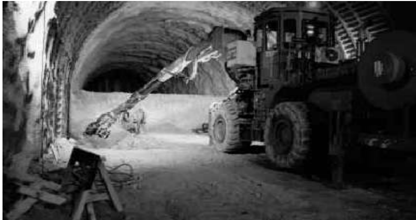
Figure II. 3: exemple du creusement en demi-section.
