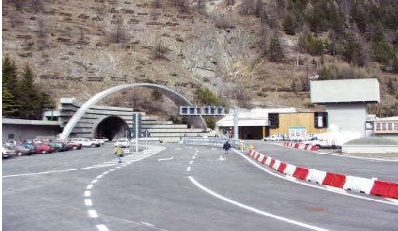
Figure II. 1: Exemple d'un tunnel (z.boutaraa 2016/2017).
