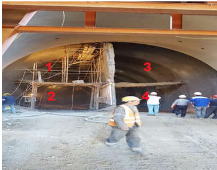
Figure IV. 6: creusement en division en 4 sections (méthode CRD (exemple))
