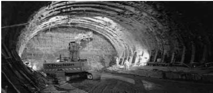
Figure II. 2: exemple de Creusement en pleine section
