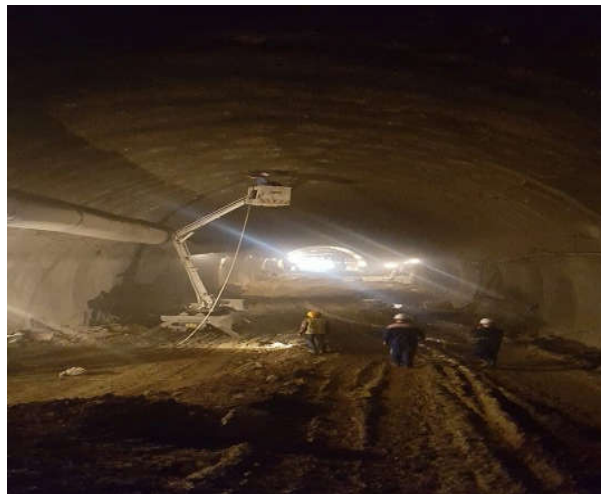
Fig. l'avancement des travaux dans le tunnel.
