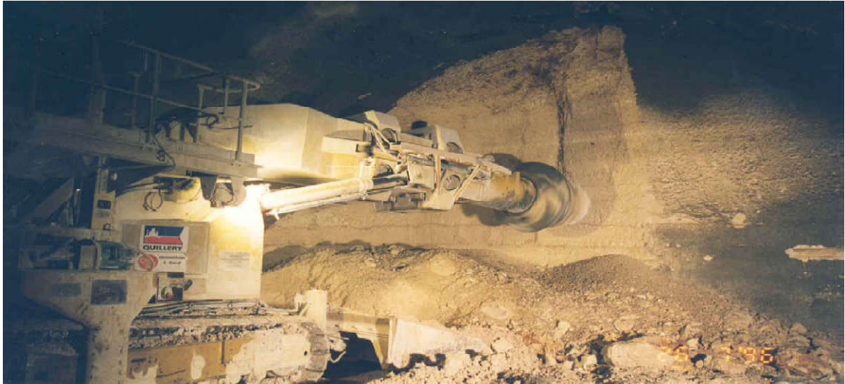
Figure II. 6: Machine à attaque ponctuelle sur le tunnel de Tartaignille (François 2012)
