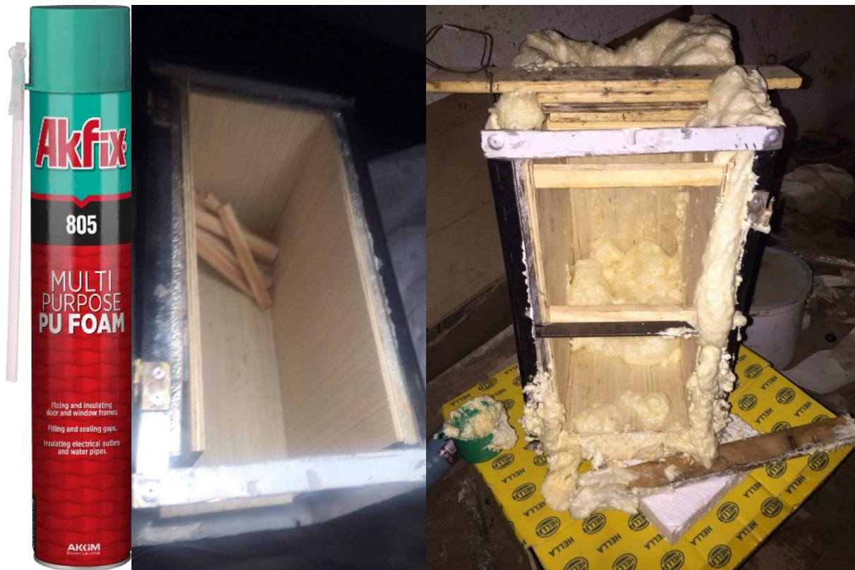
Figure 3.10 : l'utilisation de la mousse expansive Akfix et ses résultats
