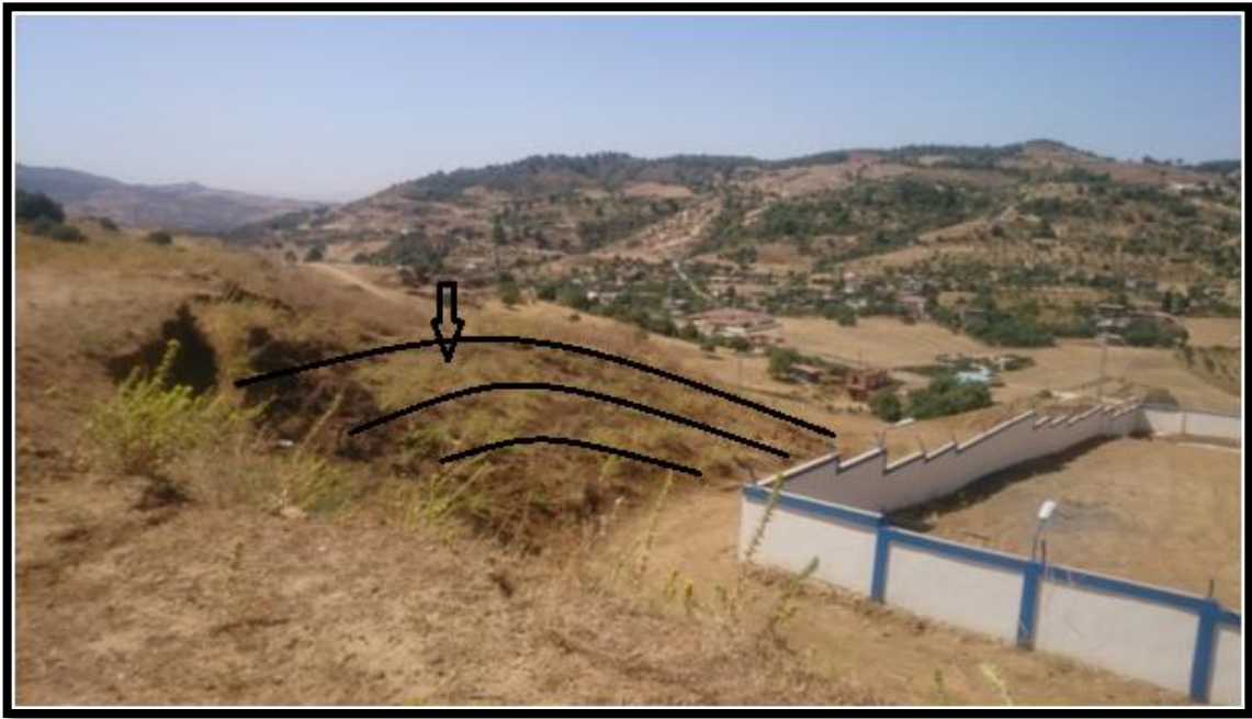
Figure 8. photo de bourrelet : effet du glissement
