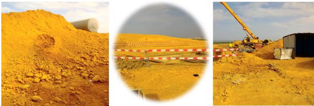
Figure III.3 : localisation de matériau utilisé dans le site (Ouled farés à Chélif)
