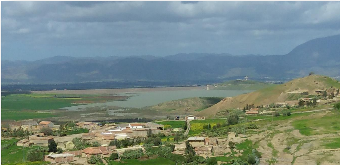
Photo 8 : Photo d'un vue générale du Barrage de Harreza (Cliché Bettassa et Tafiani 2018)
