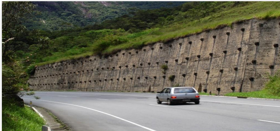
Photo 05 : Les murs de soutènement (2)
