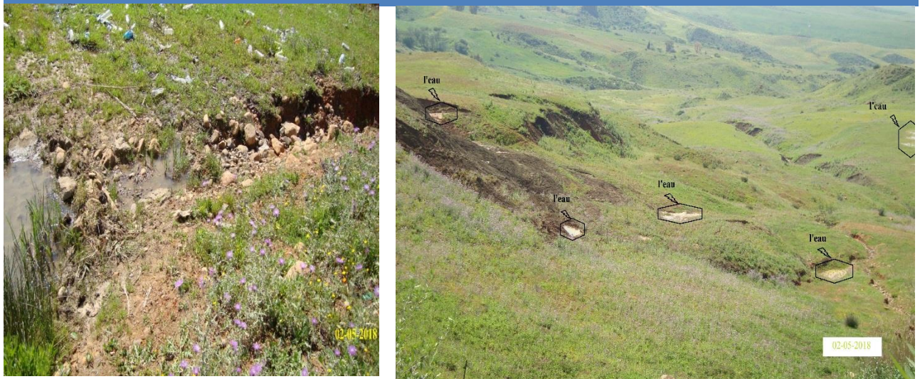
Figure II.9 : Un terrain causé par l'eau dans la section M5.
