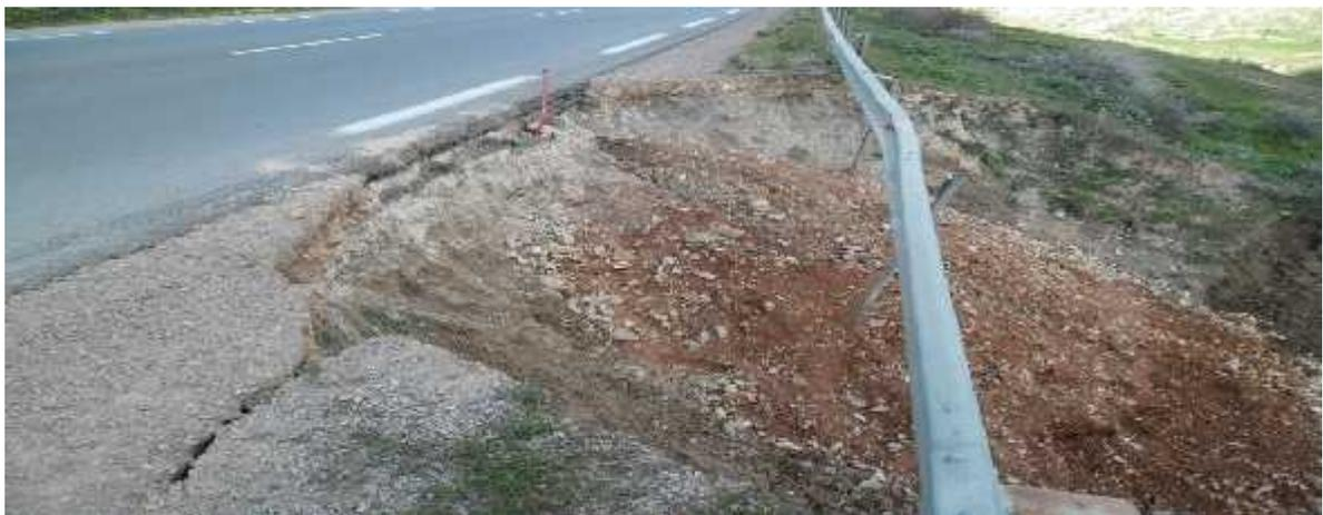
**Figure 1.** Escarpement au niveau de l'accotement
