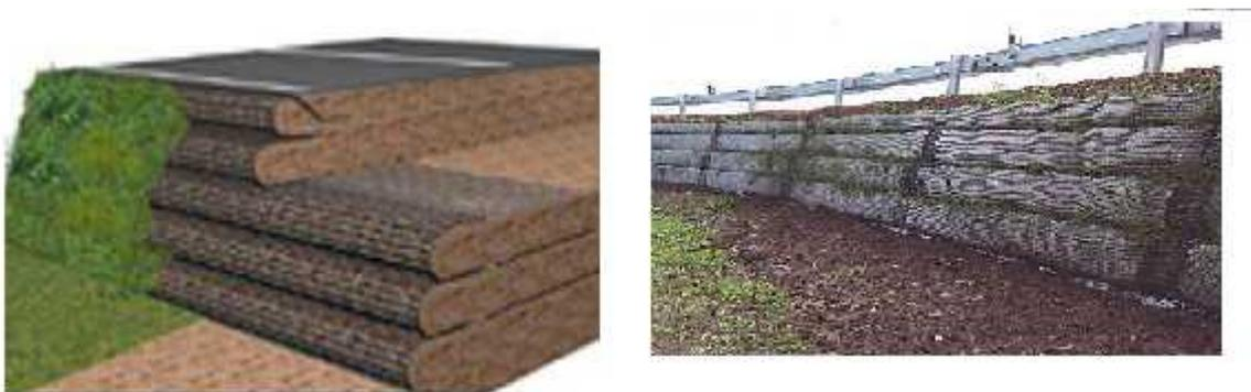
**Figure 2.**La mise en place des nappes de géogrille
