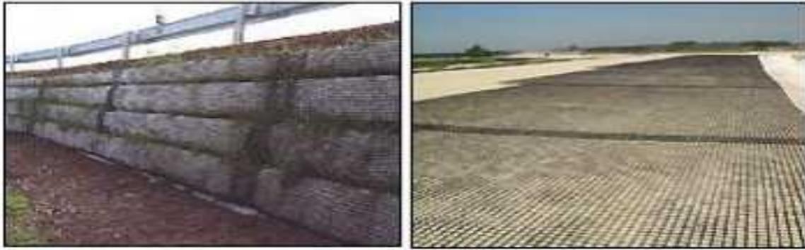
**Figure 6.** Renforcement par géo synthétique
