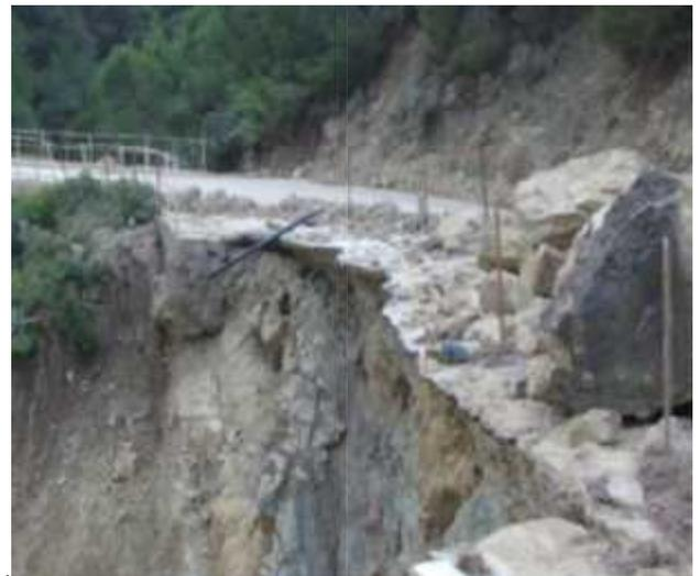
*(a) : le mécanisme de l'éroulement*
