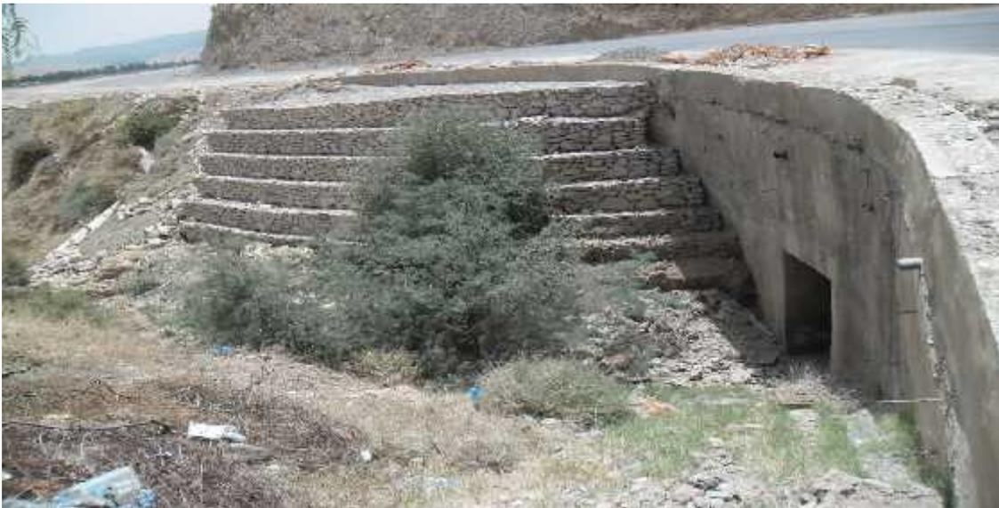
**Figure 7.** Partie des gabions et soutènement.
