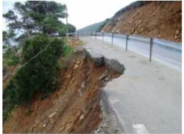
(a) : Mécanisme de glissement rotationnel simple (b) : Exemple sur RN 11, Damous, Algérie.
