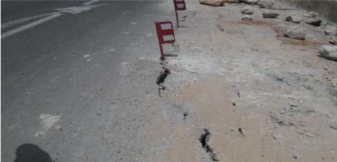
**Figure 6.** Rupture caractéristique qui affecte, la demi-chaussée suivi d'un affaissement importante recharge par la suite
