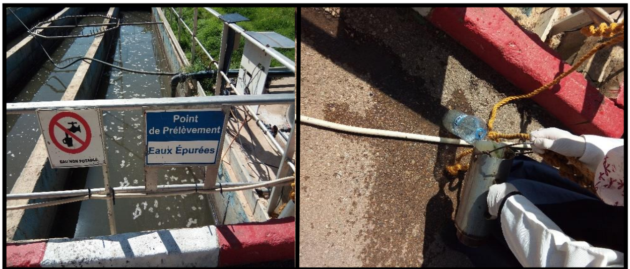
Photo 09 : Prélèvement des eaux usées traitées à la sortie (17/04/2018)
