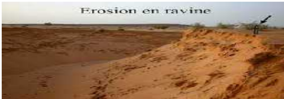
Figure03 : érosion en ravine.
