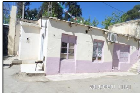
Photo n°06: Poste de surveillance.
