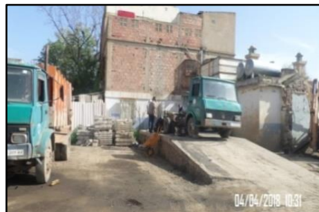
Photo n°08: Atelier de réparation.
