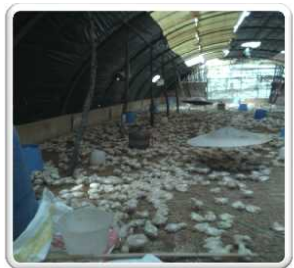
Photo 18 : Toiture en roseau.
