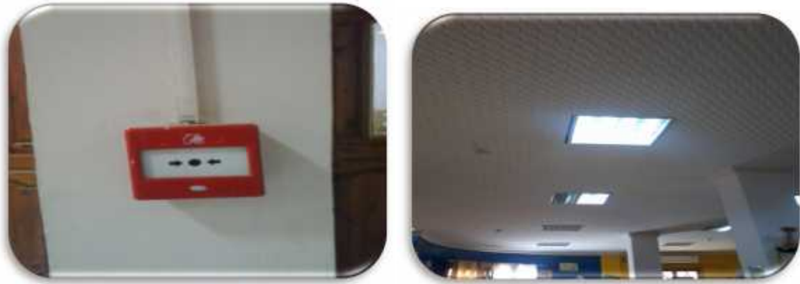
الصورة رقم (18 و 19): أجهزة الإنذار وكشف الحرائق
