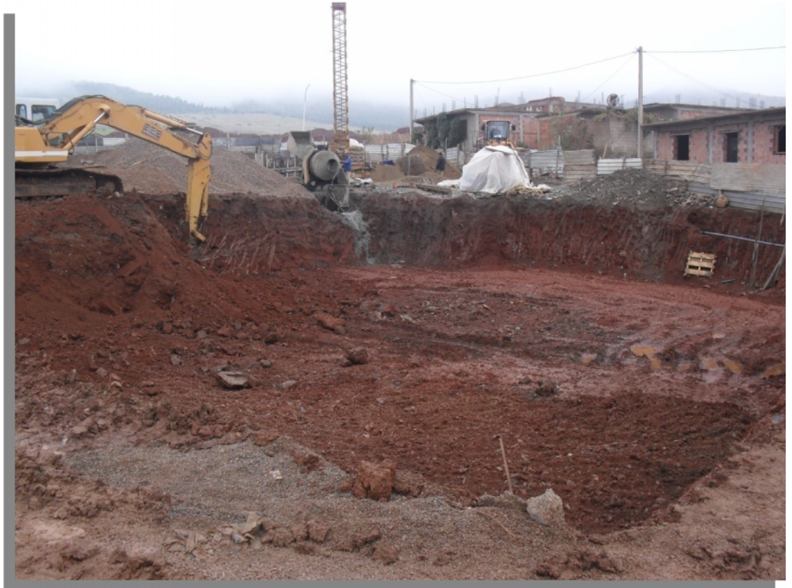
Figure I.8 : terrassement en cours.
