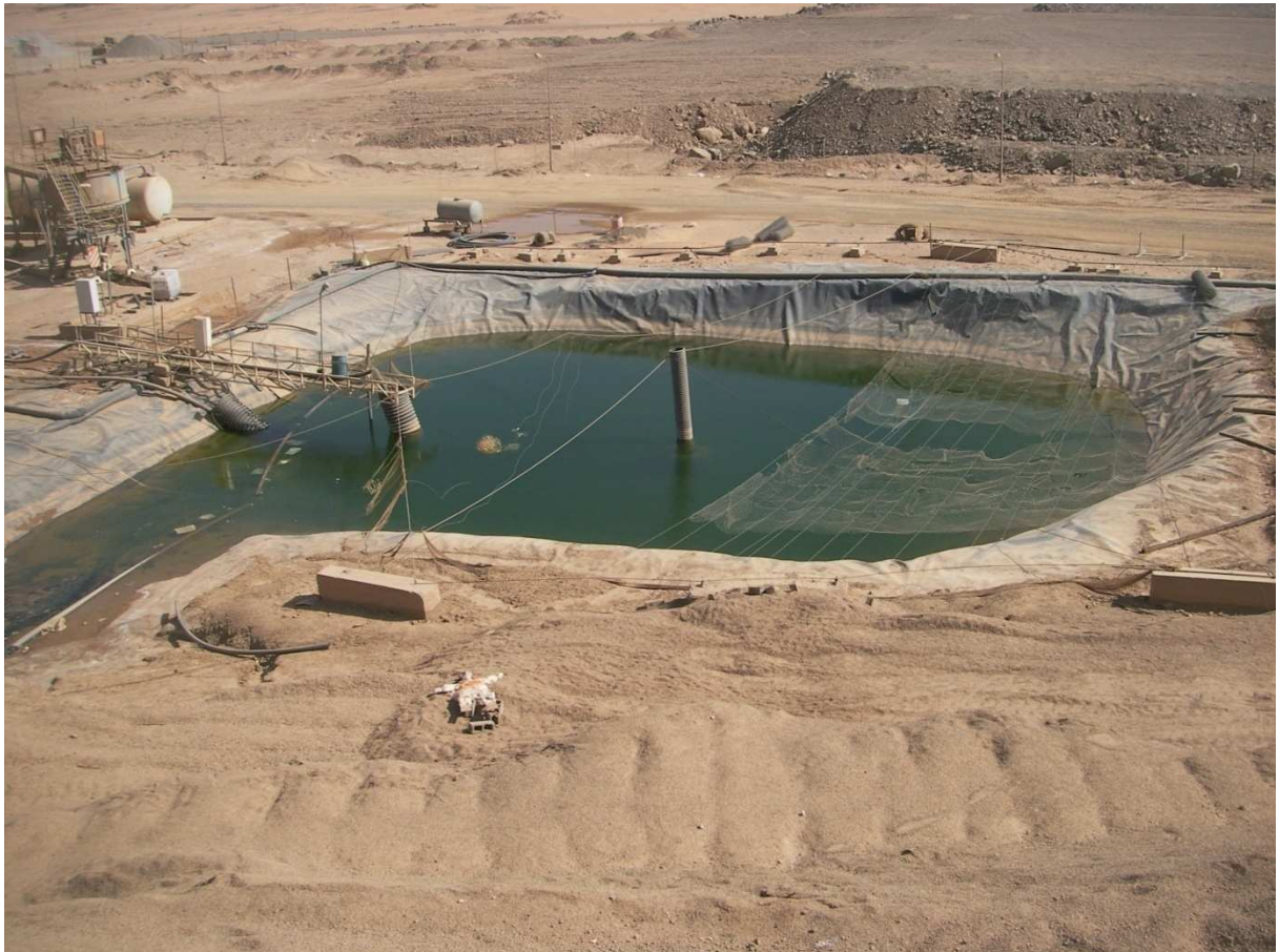
Figure II.8 : fosse de récupération de solution aurifère Amesmesssa
