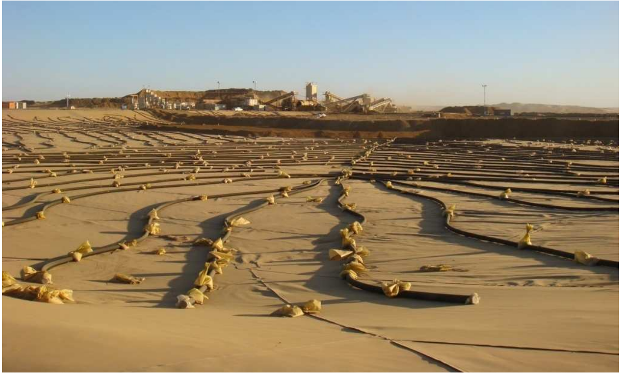
Figure II.8: Base de l'aire de lixiviation en tas , Amesmessa
