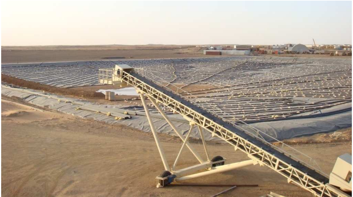
Figure .II.7: Premier Aire de lixiviation en tas d'Amesmessa
