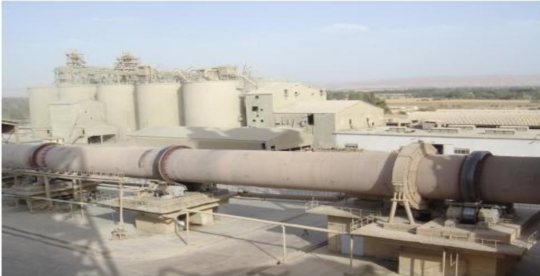
Figure II.2: Four rotatif long en voie sèche de l'ECDE [8].
