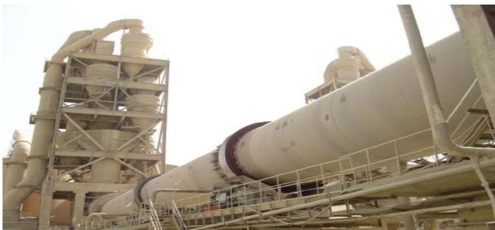
Figure II.9: Four rotatif avec préchauffeur à cinq étages de cyclones et précalcinateur.
