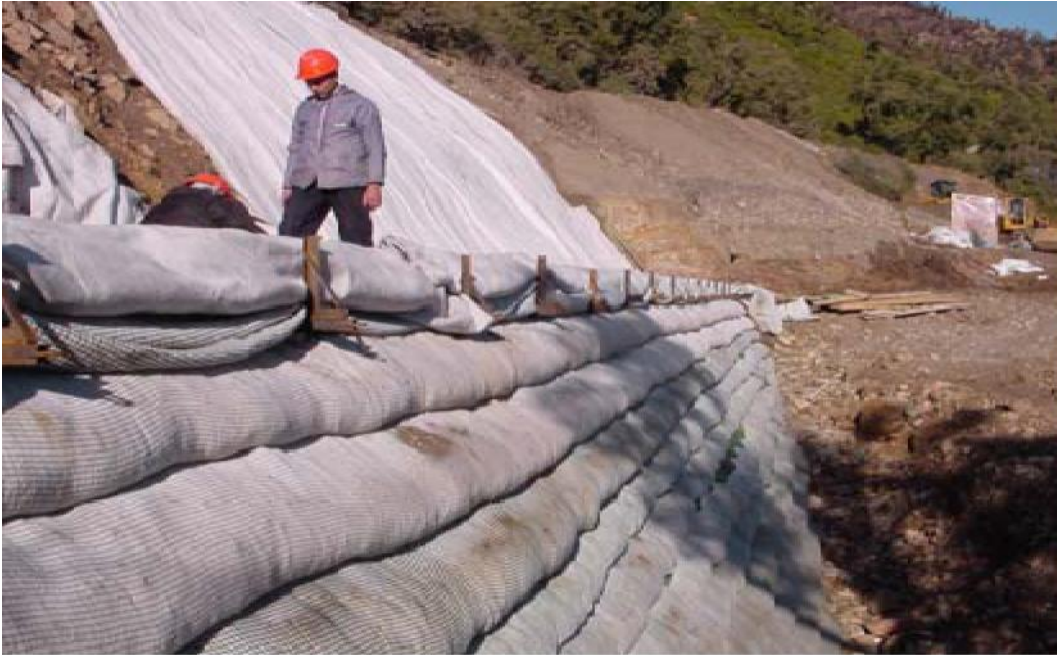
Photo1.5 : Construction de l'ouvrage par couches
