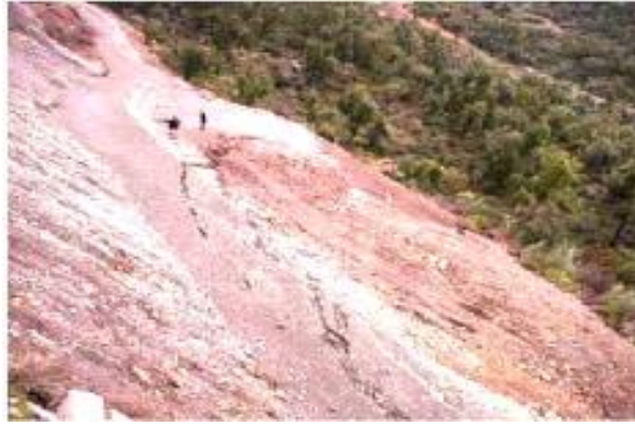
Photo 1.3 :fissures longitudinales dans la route affecté par le glissement
