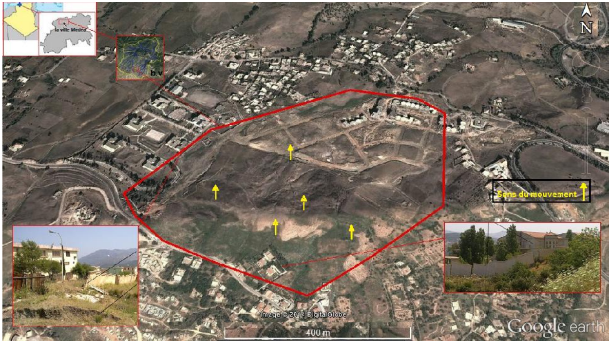
Figure 2.1. Délimitation de la zone mouvementée (Google earth 2017) avec des Photographies présentant les endommagements des constructions avoisinantes (A) des désordres au niveau du mure de la clôture de la résidence universitaire (B) une villa basculée.
