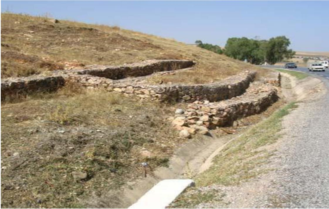
**Fig48. Protection des abords d'une route par un fossé et des murs de gabions (Algérie ANBT 2007).**
